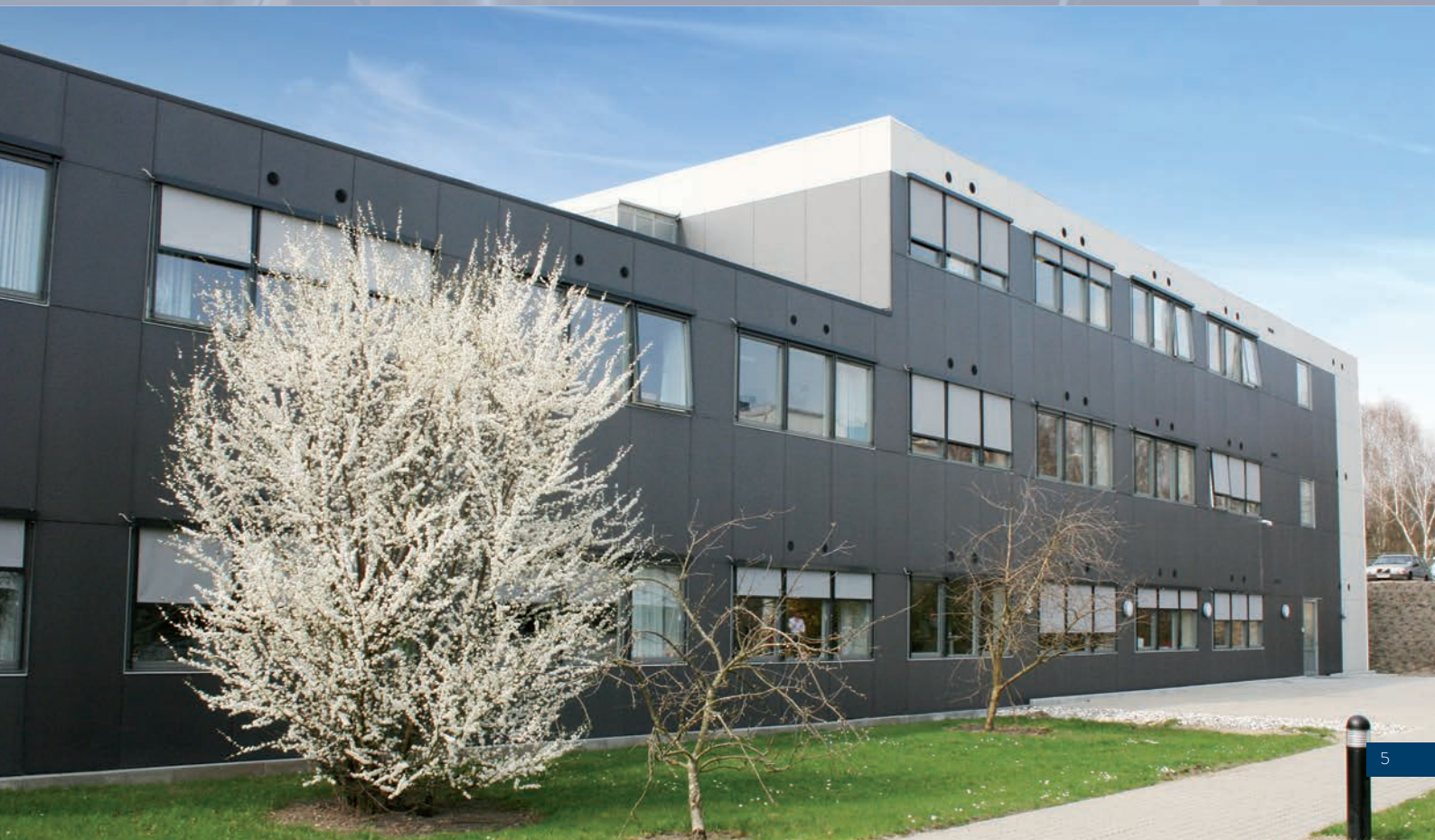
Kontorbygningen, sett utenfra. Inntak og avkast er ført ut gjennom fasaden og avsluttet med fasaderister.
